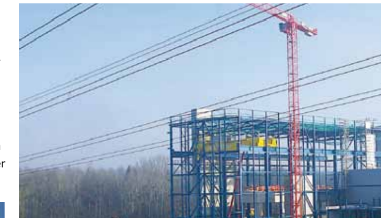
Im Herbst 2007 läuft der Stahlbau auf Hochtouren.
